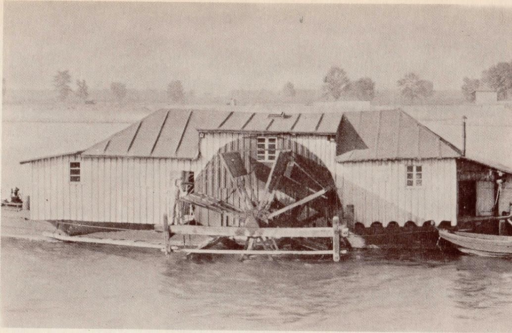
Aus einem Archiv stammt diese Aufnahme. Sie zeigt eine alte Rheinmühle, wie sie im Nackenheimer Mühlarm vor Anker lagen. Sie waren ganz aus Holz gebaut und hatten keinen Tiefgang. Die durchschnittliche Länge betrug 30 Meter. Der Müller wohnte selbstverständlich an Bord der schwimmenden Mühle.
